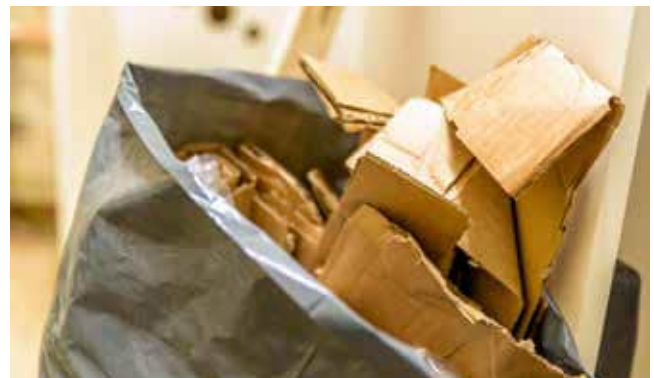
Erhöhte Brandlasten und versperrte Fluchtwege: Lagerungsproblematik auf Baustellen (Foto: Shutterstock)
